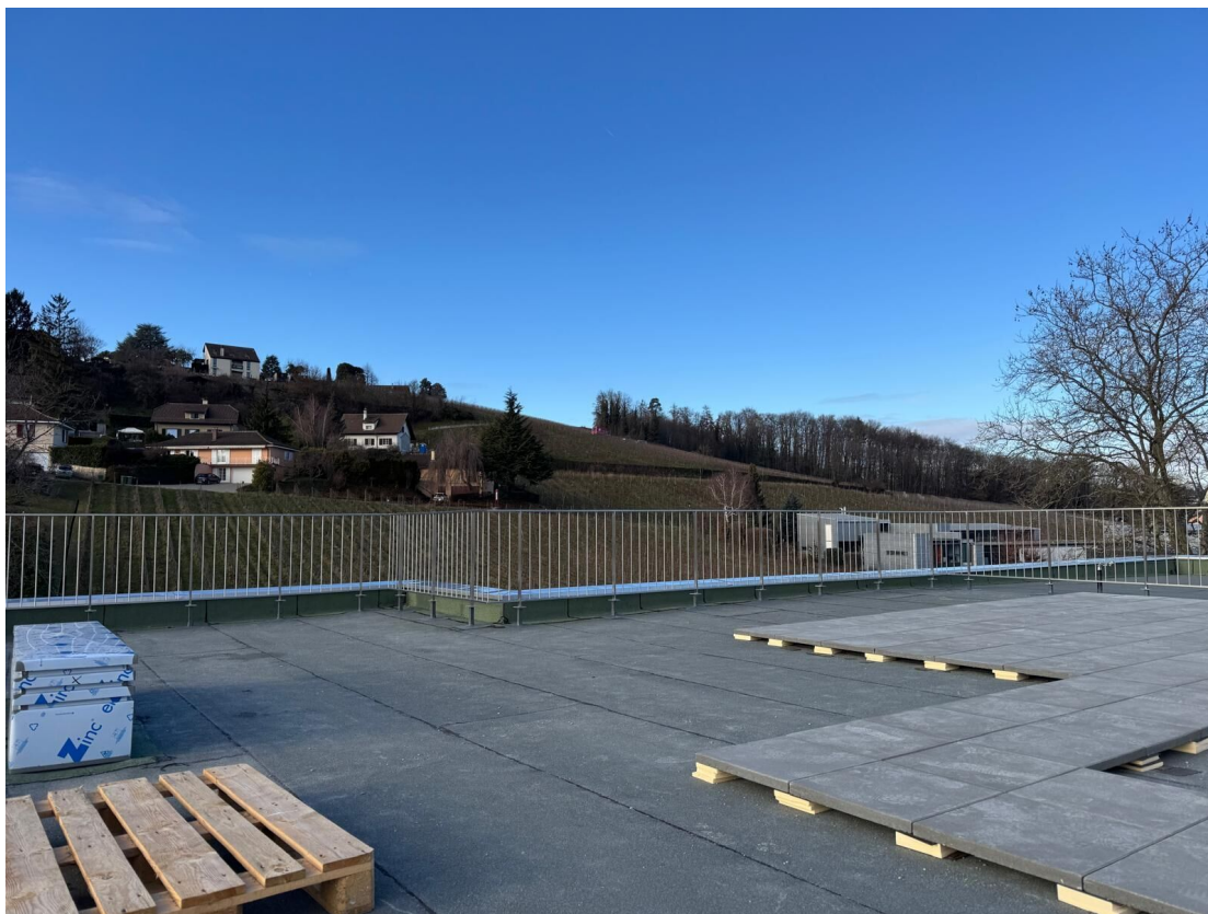
Terrasse en toiture (en cours d'aménagement)
