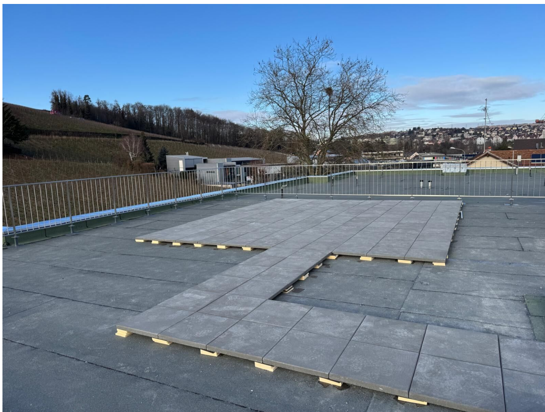
Terrasse en toiture (en cours d'aménagement)
