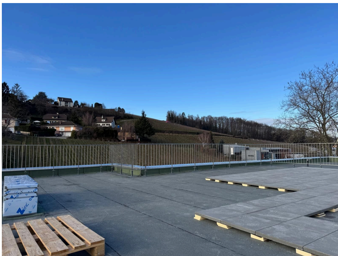
Terrasse en toiture (en cours d'aménagement)
