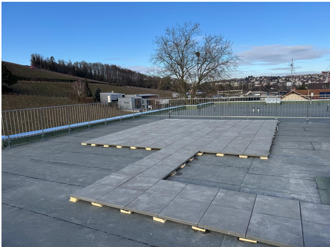
Terrasse en toiture (en cours d'aménagement)
