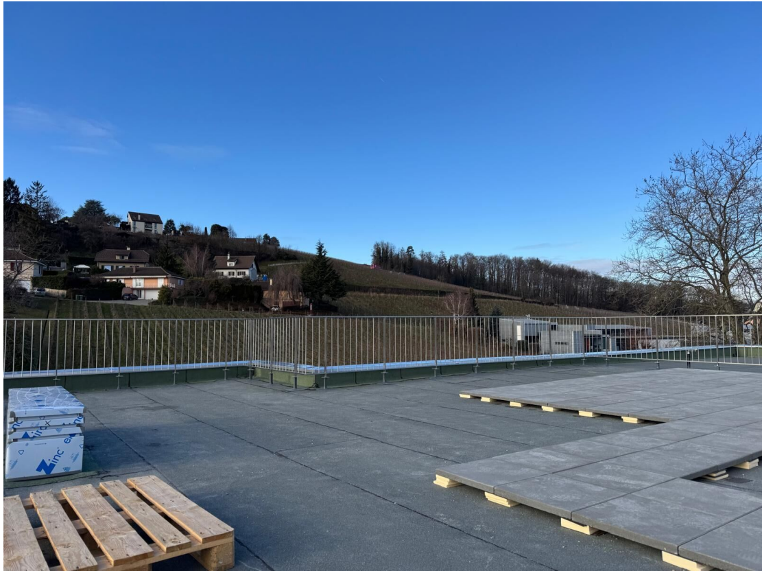
Terrasse en toiture (en cours d'aménagement)
