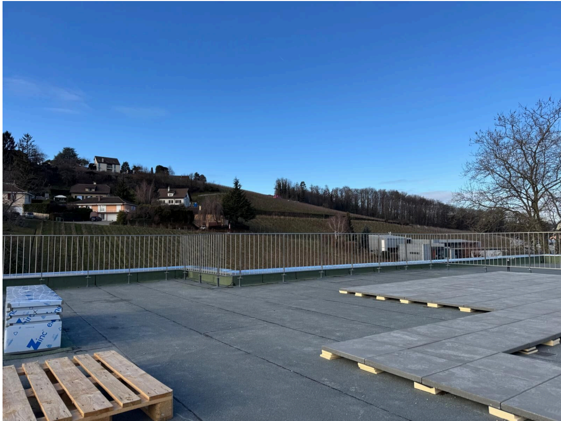
Terrasse en toiture (en cours d'aménagement)
