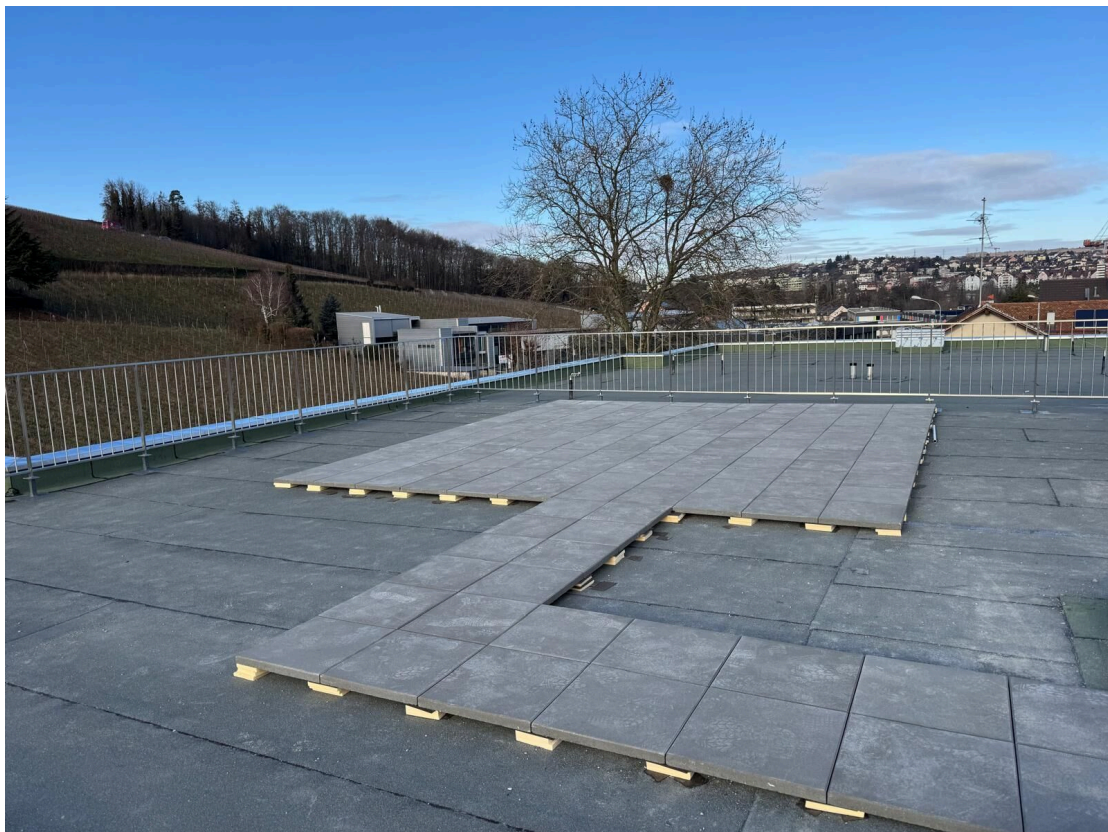
Terrasse en toiture (en cours d'aménagement)
