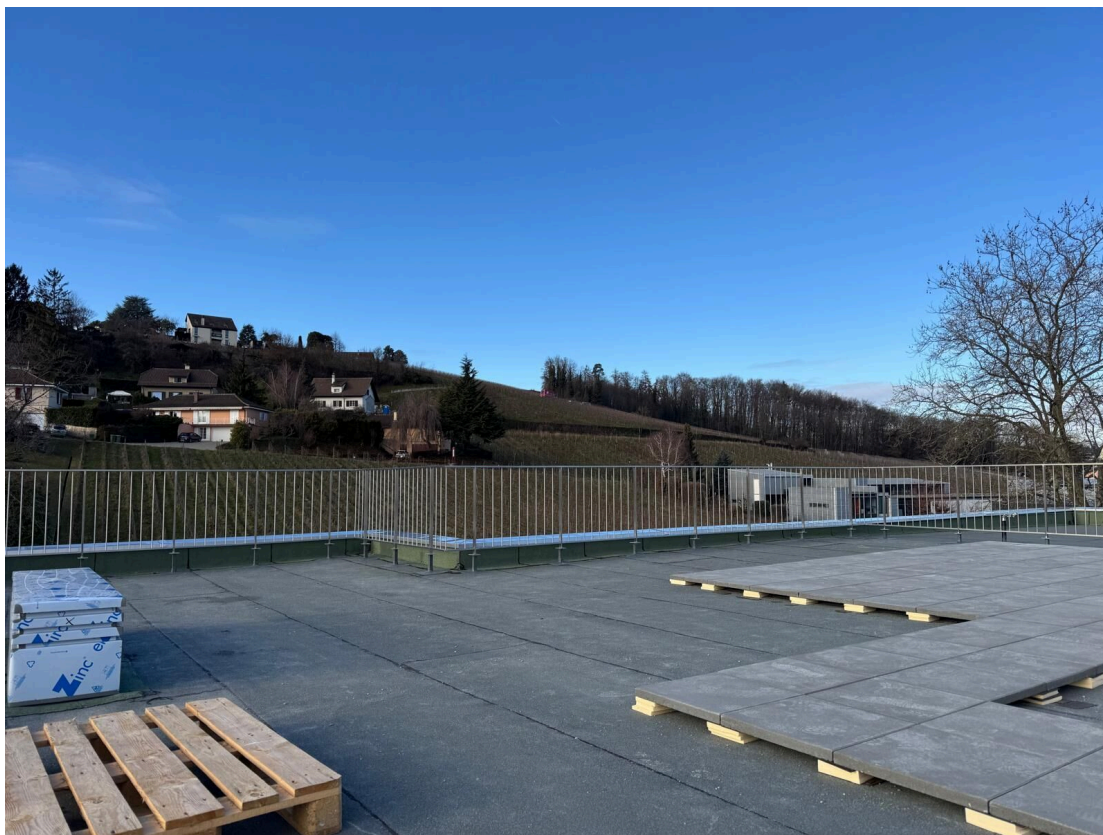
Terrasse en toiture (en cours d'aménagement)
