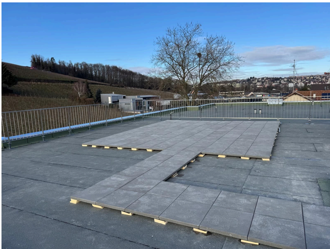
Terrasse en toiture (en cours d'aménagement)
