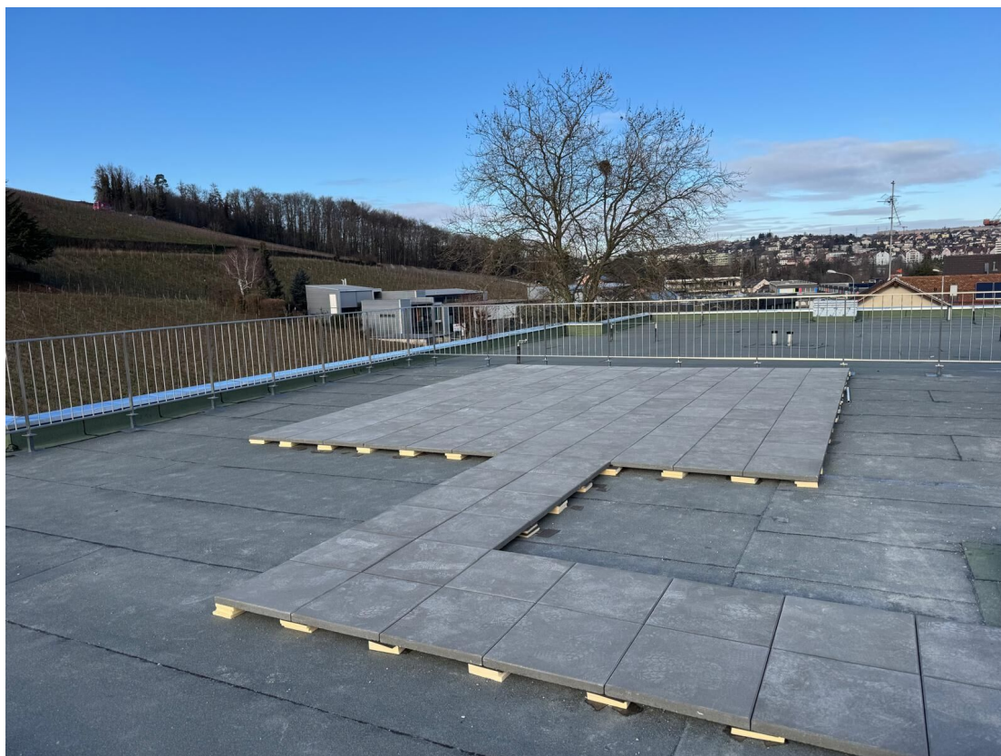
Terrasse en toiture (en cours d'aménagement)
