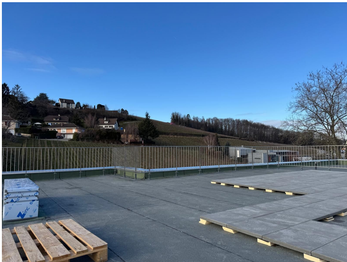
Terrasse en toiture (en cours d'aménagement)
