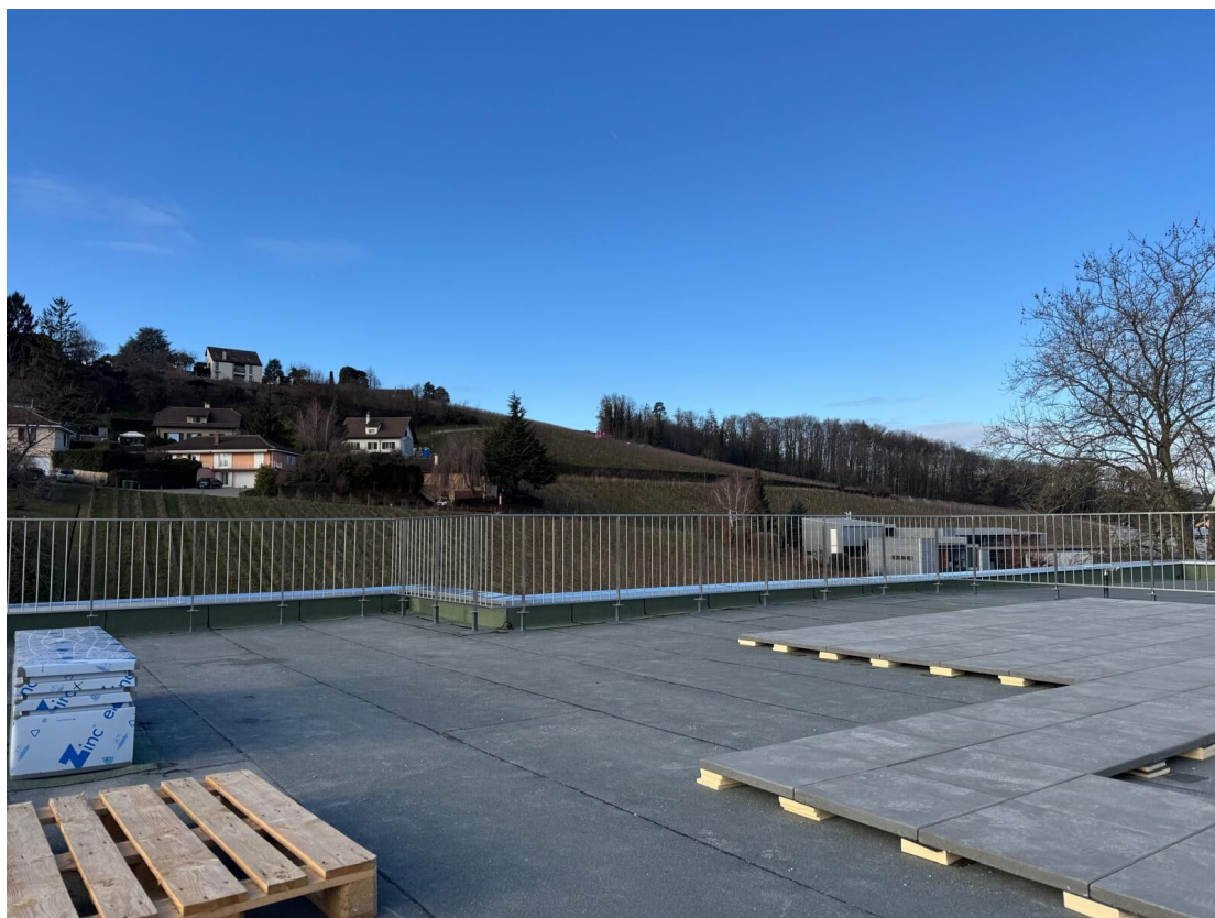
Terrasse en toiture (en cours d'aménagement)
