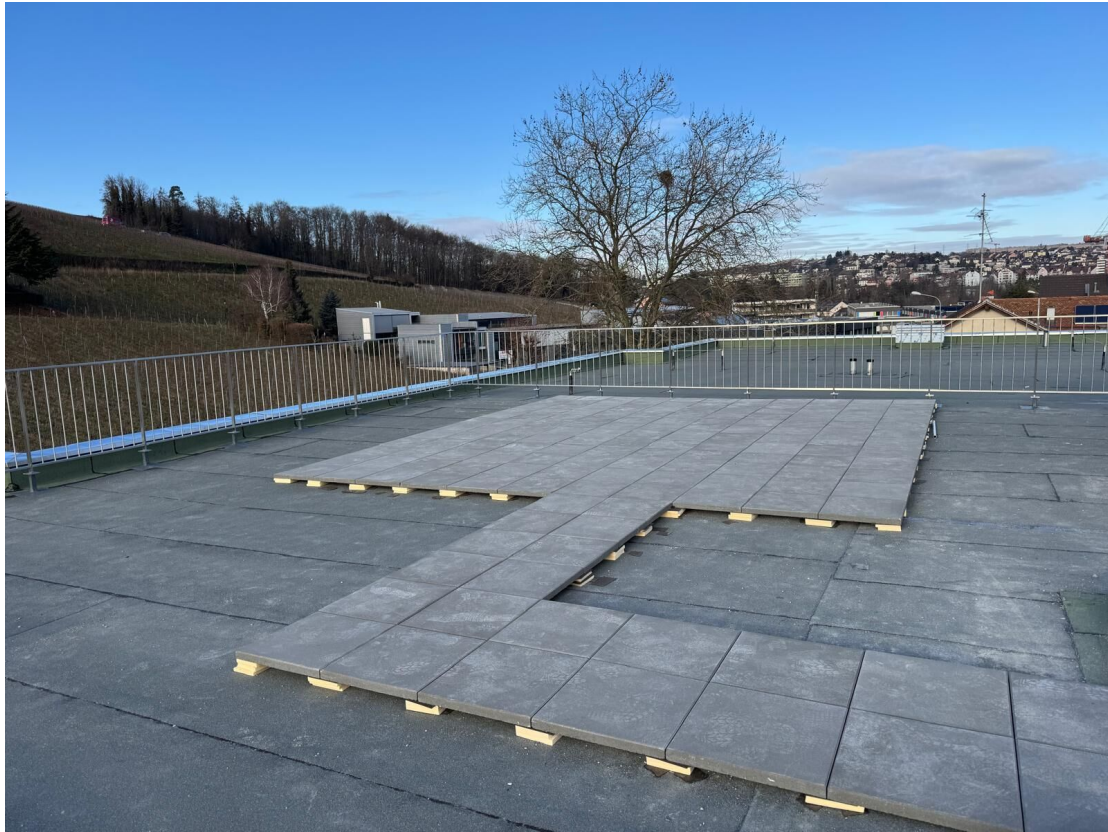
Terrasse en toiture (en cours d'aménagement)
